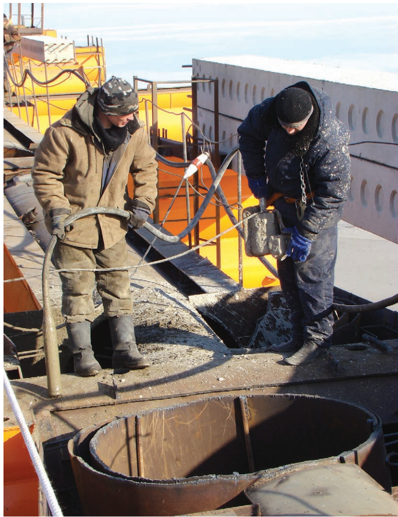
Подготовку к бетонированию свай причала ведут бетонщики А. Смелый и А. Животов
