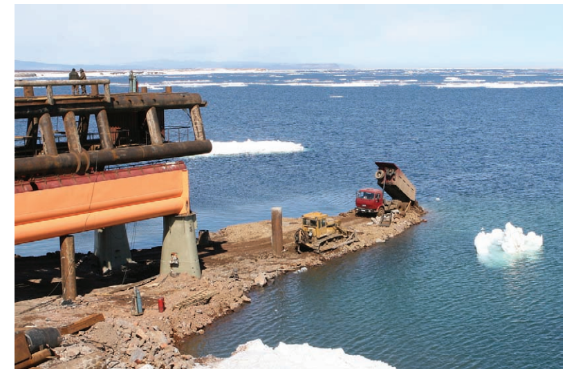
Начало строительства глубоководного причала в бухте Мучке Construction of the deep draft pier at Muchke Bay started
