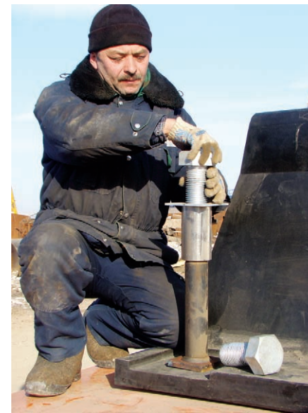
Установка болта-крепления отбойного устройства причала. Слесарь С. Алмаиди
