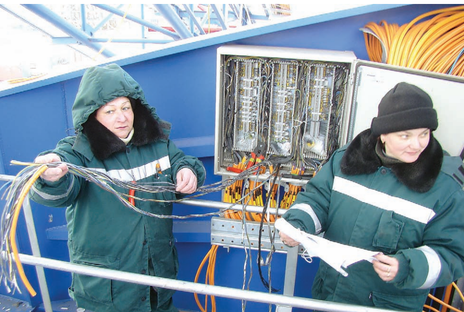
Электрослесари Хабаровской ремонтно-монтажной компании В.А. Лабуз и Т.А. Вершинина
